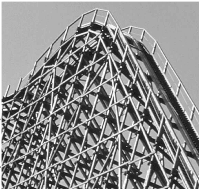
Photo: Stig Kälverud, Liseberg.
