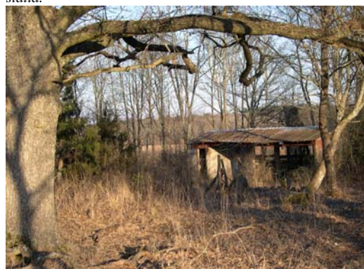
Foto A:6. I området finns en del bebyggelse lämningar från Säby gamla tomt. Dessutom finns modernare lämningar i form av ett skjul med en gammal mjölkkningsmaskin.
