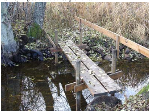
Foto A:16. En nybyggd bro över Säbyån.
