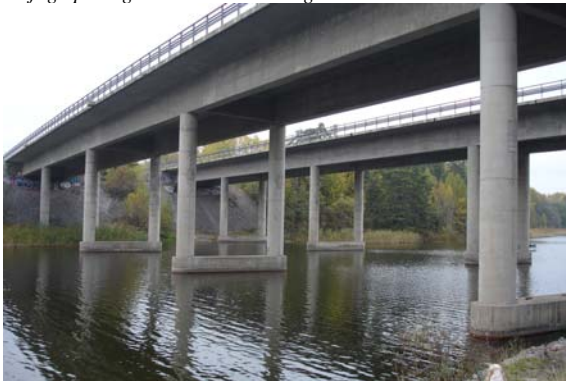
Foto D:7. Här tar det stopp! E4-bron från det södra fästet.
