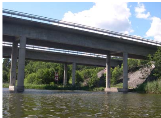
Foto C:9. Bron över Valloxen mot det norra fästet.
