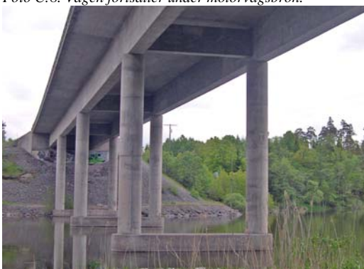
Foto C:10. Varje körfält av motorvägsbron bärs upp av 4 pelarpar. Valloxen är här cirka 50 meter bred. Foto från norra brofästet.
